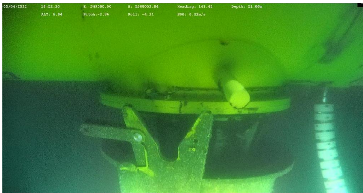
Figure 14 : photographie illustrant les difficultés rencontrées lors de l'encastrement de la nacelle dans l'embase.
