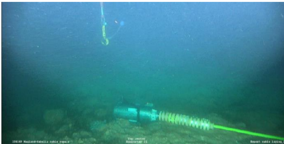
Figure 21 : connecteur posé sur le fond
