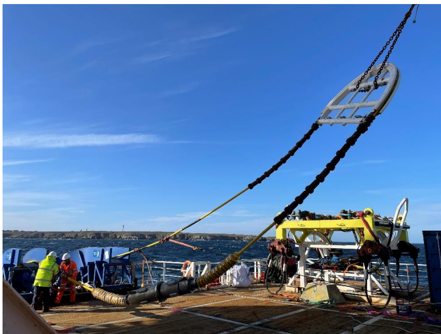
Figure 22 : immersion de la connectique
