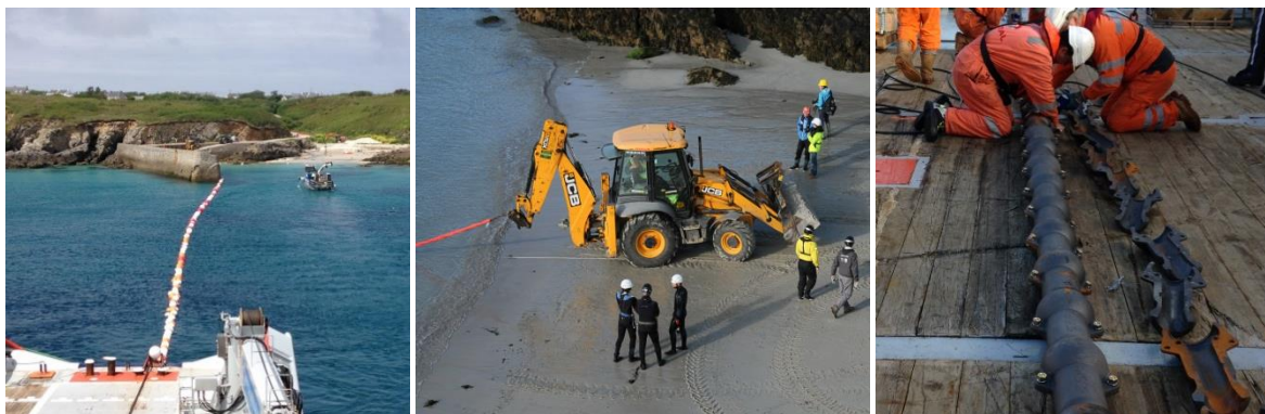
Figure 12 : Positionnement de l'Argonaute – traction du câble sur la plage – mise en place des coquilles (SABELLA)
