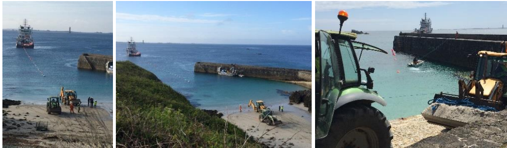
Figure 19 : Les moyens pour l'installation du câble au niveau de l'estran (SABELLA)
