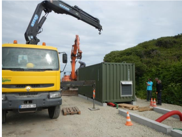
Figure 21 : Installation du conteneur de conversion et de contrôle (SABELLA SAS)
