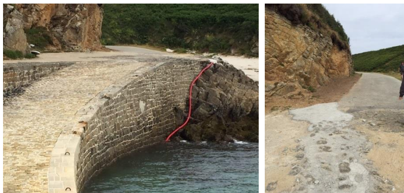
Figure 20 : Passage du câble après la cale et le long de la falaise (SABELLA)
