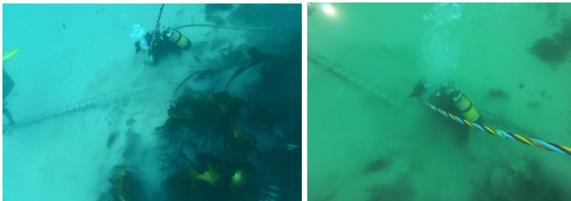
Figure 14 : Ensouillage du câble sur la partie sableuse (SABELLA)
