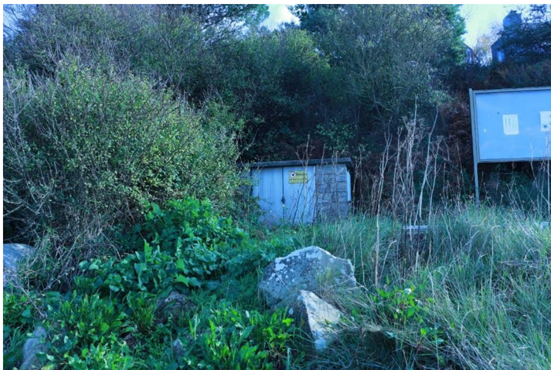
Figure 67 : Poste de relevage situé en haut de la plage du Tréno, Arzon (UBS, 2018)
