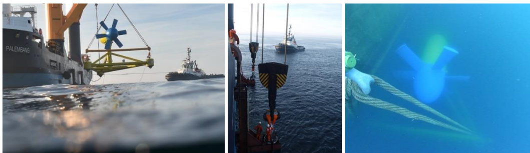
Figure 16 : Mise à l'eau de l'hydrolienne (SABELLA)
